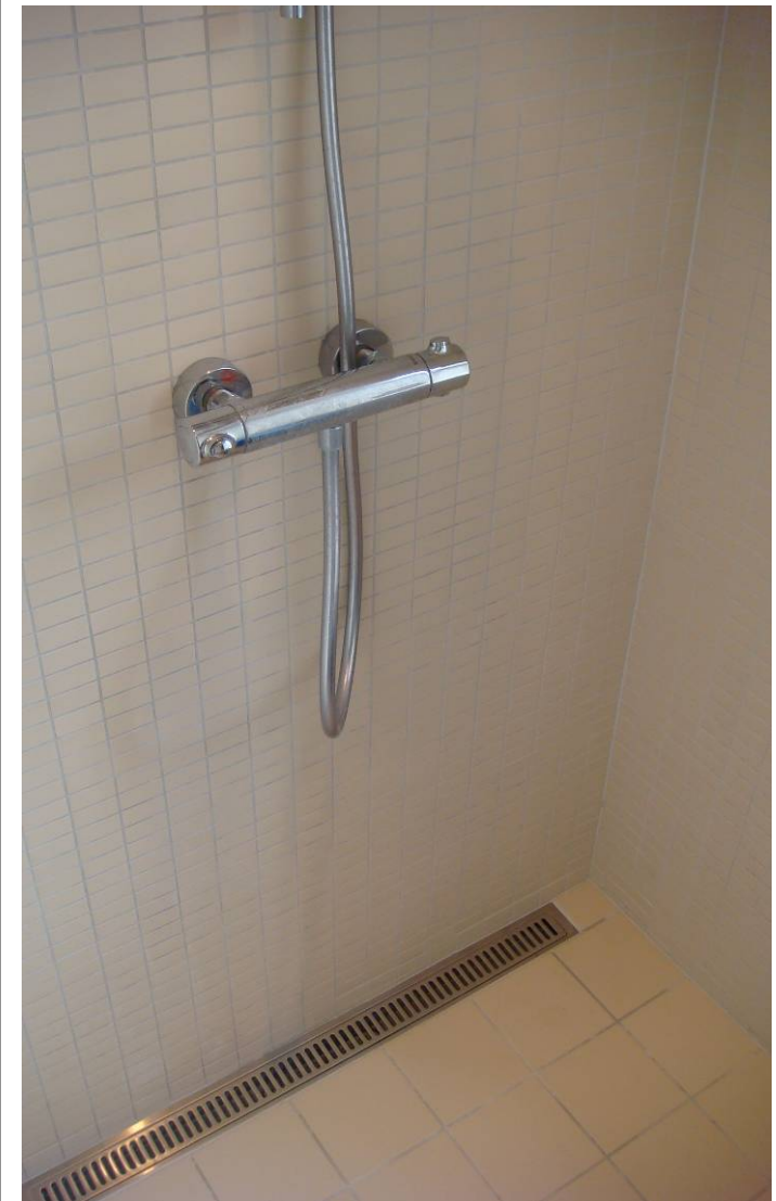
Afløbet er her et unidrain – dvs. med ensidigt fald på gulv
