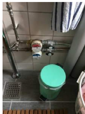
Nye koblingsledninger i lejlighed med vandmålere for koldt og varmt vand.
