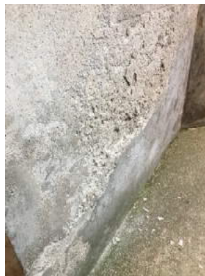
Afskalninger på trappevange
