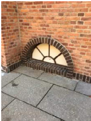
Sokkel udført i hårdtbrændte sten.
