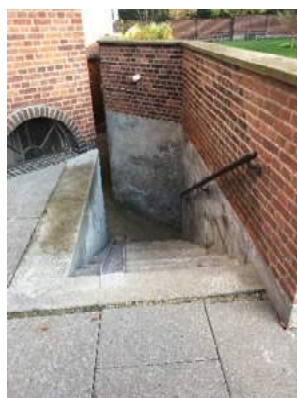
Kælderskakt – betontrappe og -vanger.
