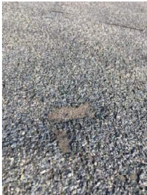
Der ses flere plamager af ubeskyttet tagpap, hvor skifergranulat er slidt væk. Her set i nærheden af ovenlyskuppel.
