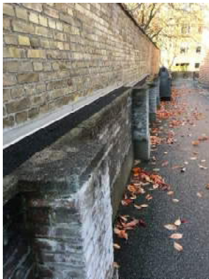
Mur mod nabo til Valby Laggade
