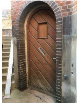
Kælderdør ved kælderskakt
