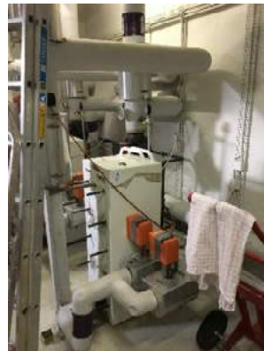
Varmevekslere i varmecentral
