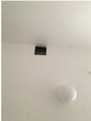
Åbning til udluftningskanal fra wc
